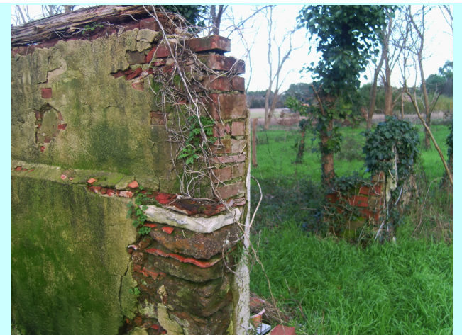
Moulin Neuf vestige de la maison du meunier
